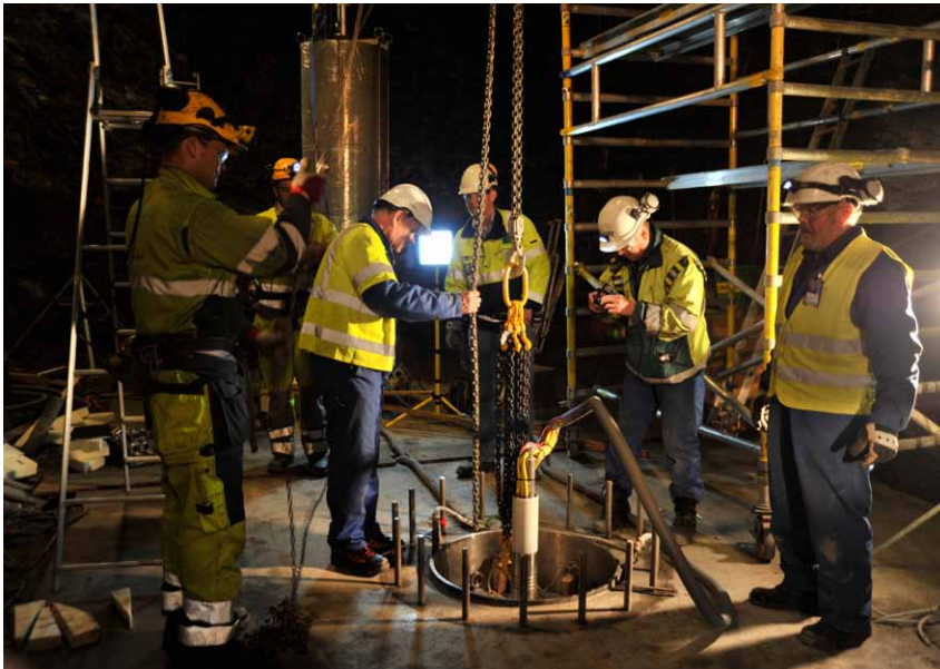
Arbete med ett granitblock i forskningstunneln i Onkalo.
